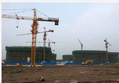
新キャンパス建設現場
